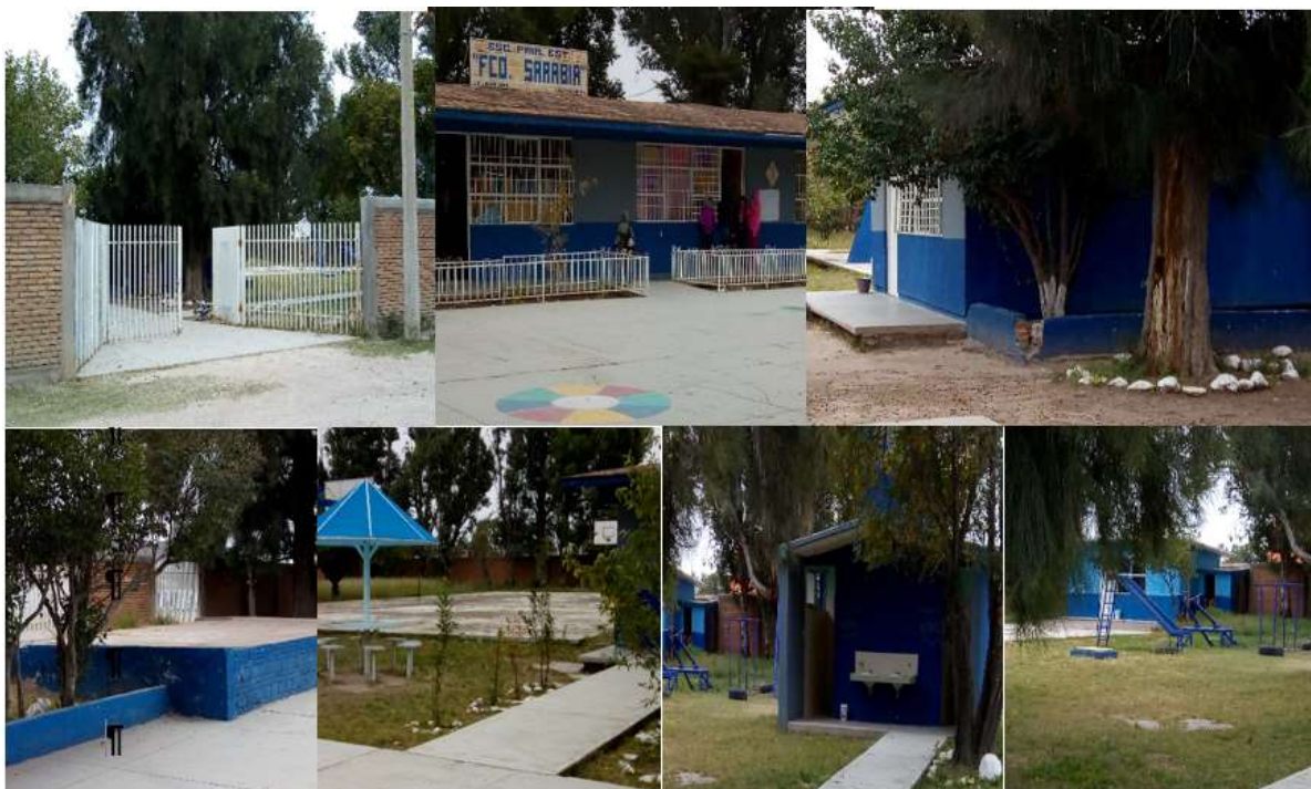
Figura 3: Infraestructura de la primaria “Francisco Sarabia”
